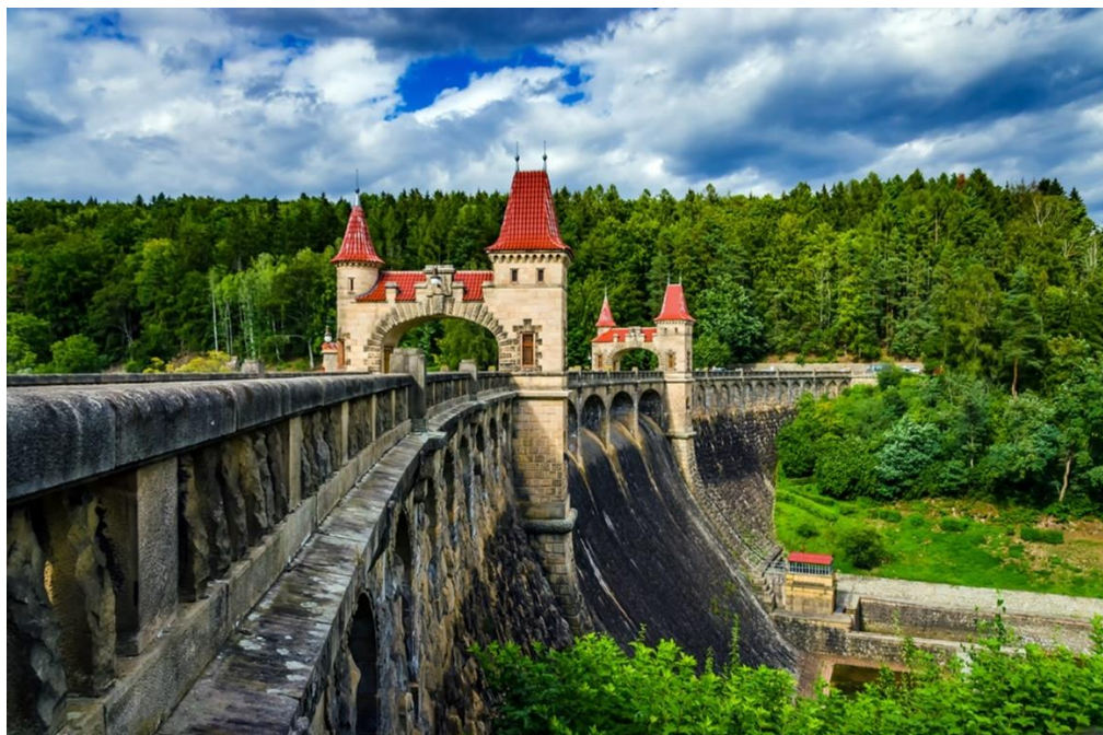
Obrázek 9: Přehrada a vodní elektrárna Tešnov – vodní dílo Les Království
