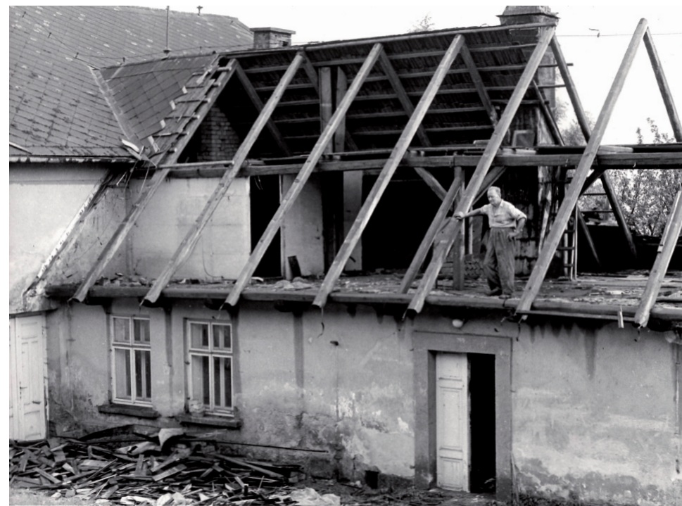
Fotografii demolici kulturního domu provedl královédvorský občan I.8.1980. Demolici střechy provedli: Kudrnovský F., Btrych S. Šulc L. Zoufalý B. Zoufalý J. S demolici se započalo 26.7.1980, a skončeno 9.8.1980. Větší část stavby s cihel odstranil Ervert
